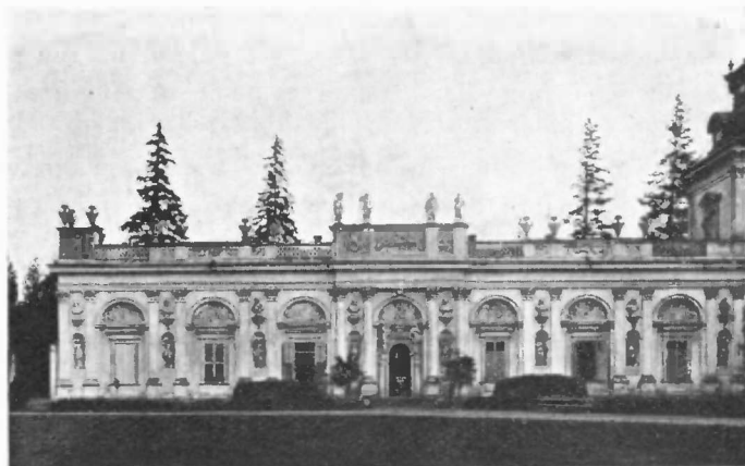
Ryc. 30. Wilanów. Elewacja bocznego skrzydła pałacowego od strony dziedzińca przed restauracją.
