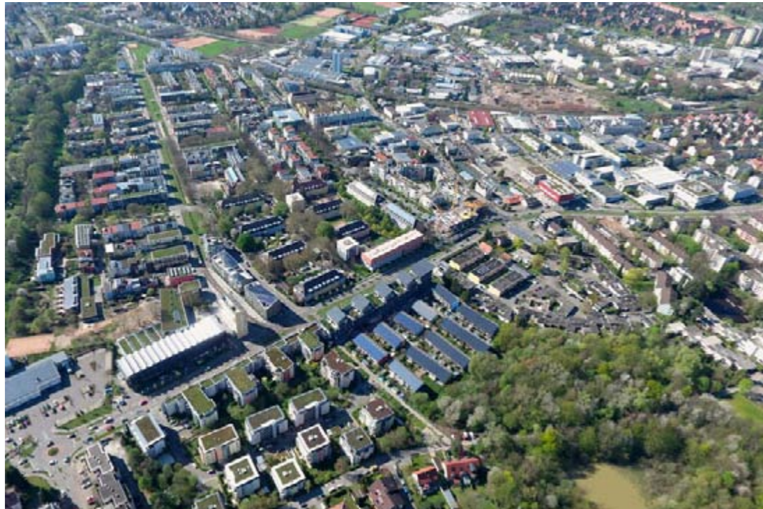
Rys. 3. Widok lotniczy całości osiedla Vauban we Freiburgu
