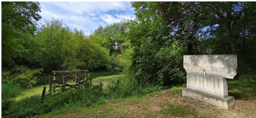
Fot. 4. Niszczące pozostałości repliki mostu i płyta ze schematycznym opisem przeprawy (fot. K. Wydra, 8 sierpnia 2026 r.)
