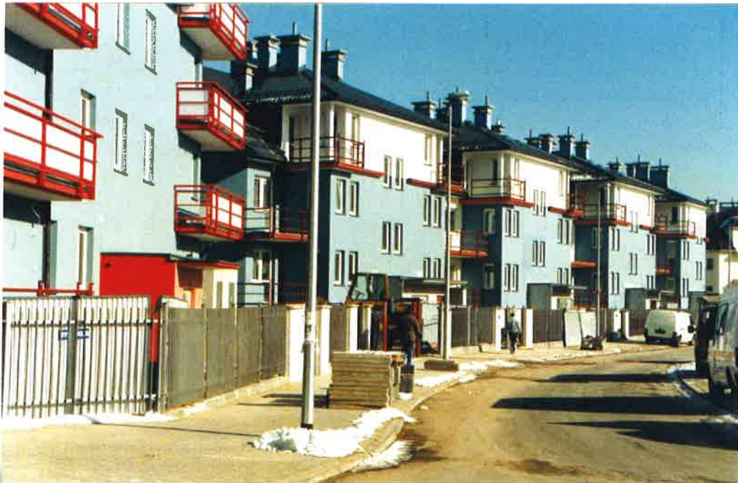
fot 3. Widok ogólny osiedla, budynki wielorodzinne w zabudowie tańcuchowej.
