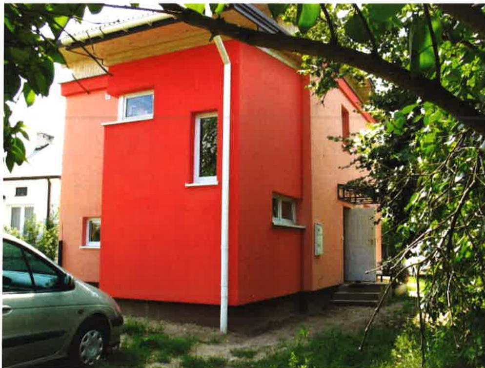
fot 8. Rozbudowa domu jednorodzinnego w Skolimowie
